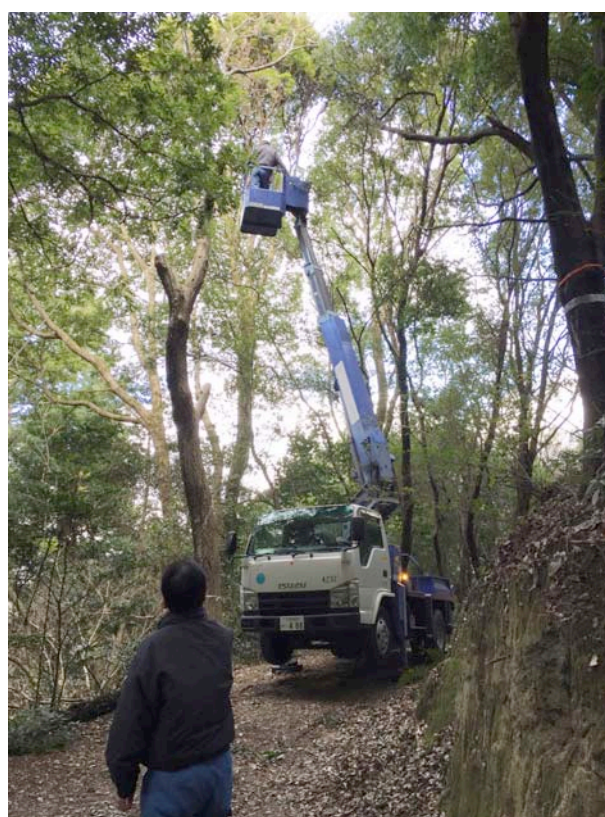
高所作業車による被害木の処理
