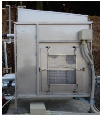
流下液膜熱交換器
