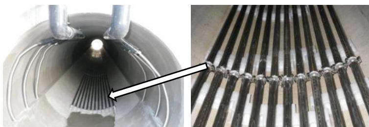
下水管内熱交換器
